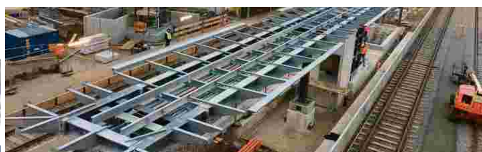
Umbau/Modernisierung des ÖBB-Bahnhofs in Braunau
